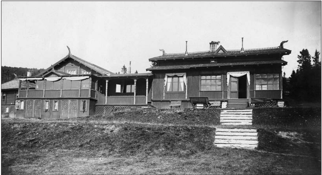
Gålå er vakkert bygget, uttalte Fröding.
